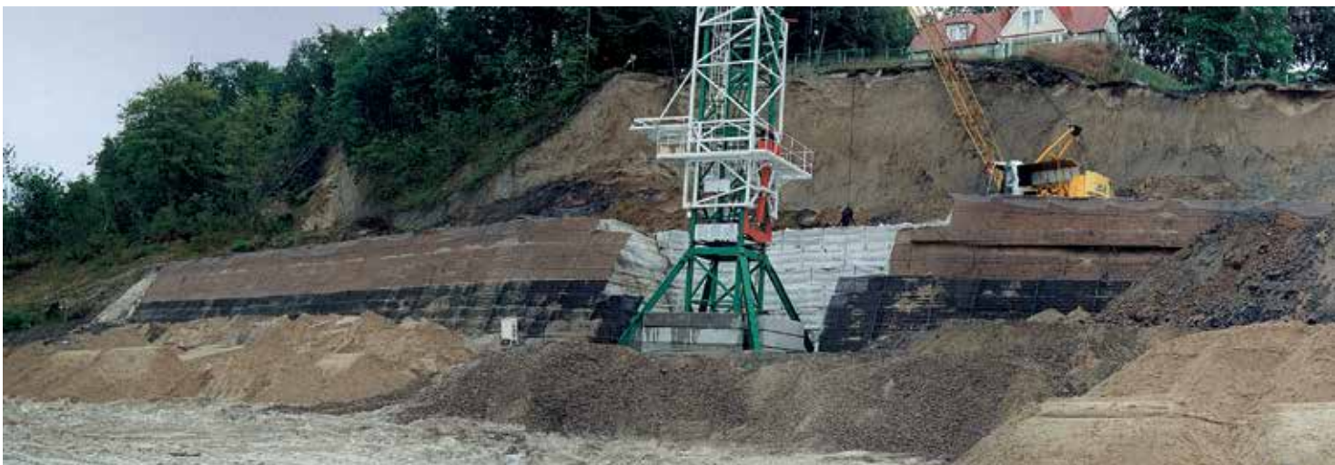
54. Slope stabilization, Jastrzebiej Gorze-Poland.
